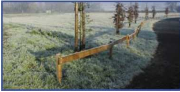
BARRIERE FIXE en planches de 145 x 38 mm fixée sur un piquet de 90 X 90 mm. Elément de 300 cm. Hauteur de 40 à 80 cm.
