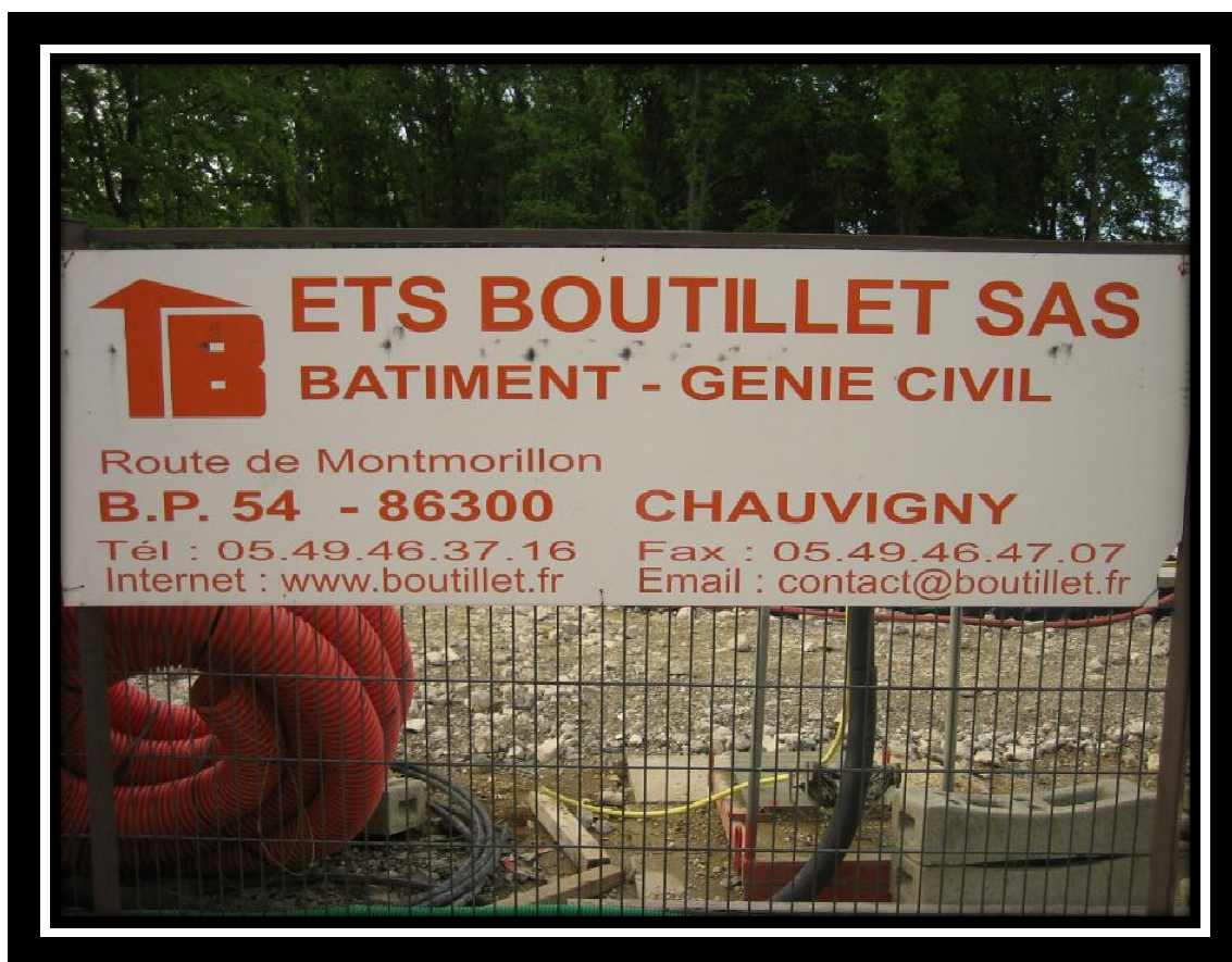
Photo 18 : Pancarte de l'établissement Boutillet sur le chantier de la piscine du Mortier (Photo personnelle)
