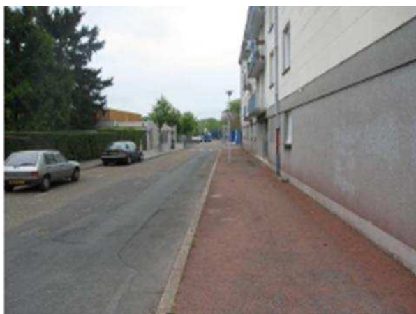
Photo 14: Rue d'Arras avant les travaux (source : Fiche opération de la mairie de Tours)
