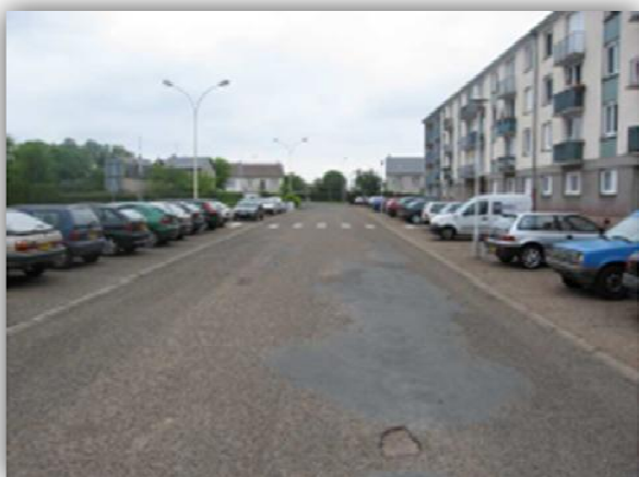
Photo 11: Avenue de Roubaix avant les travaux (source : Fiche opération de la mairie de Tours)
