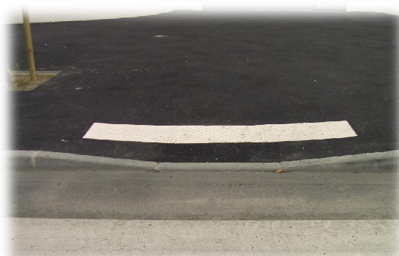
Photo 27: Trottoir et passage piéton devant le collège de la Bruyère sur la rue de Roubaix réaménagée (Photo personnelle)
