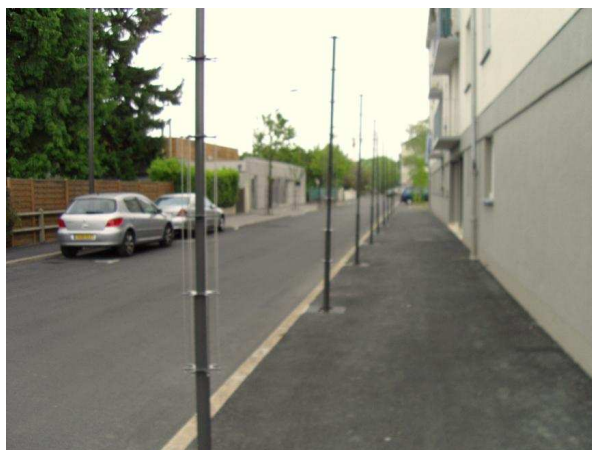
Photo 15 : Rue d'Arras après les travaux (Réalisation personnelle)
