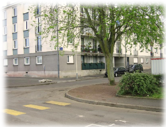
Photo 2: Accès 1 par la rue de la Brassée (Photo personnelle)
