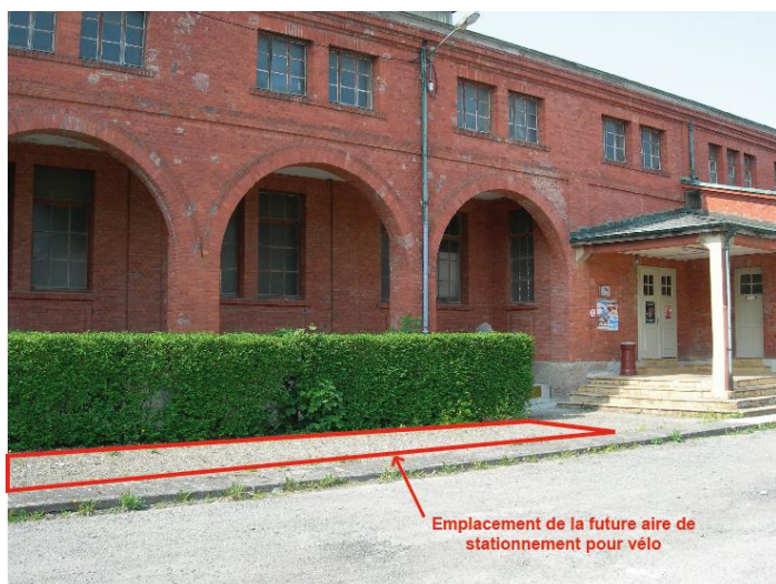
Photo 41 : Emplacement de l'aire de stationnement pour vélo
