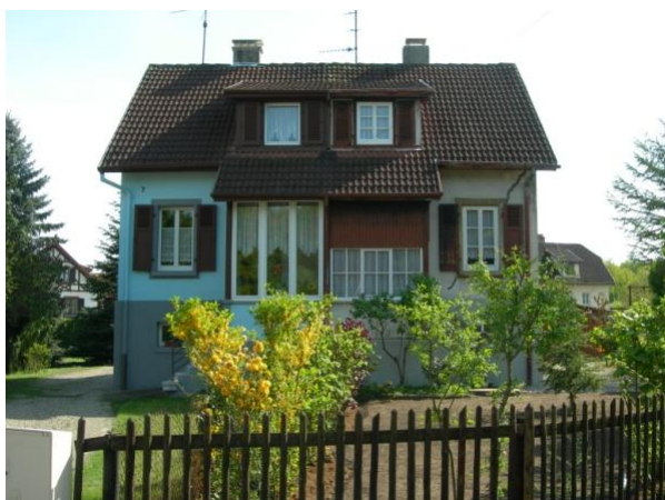
Photo 23 : Les maisons d'ouvriers à 2 logements
