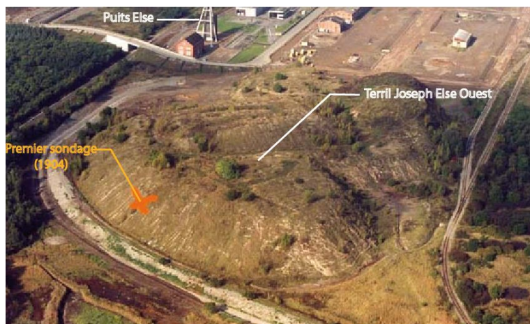
Photo 4 : Emplacement du premier sondage
