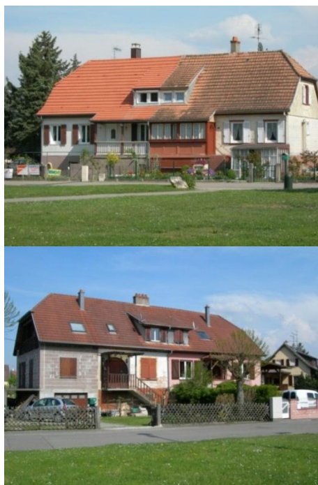
Photo 22 : Les maisons d'ouvriers à 4 logements
