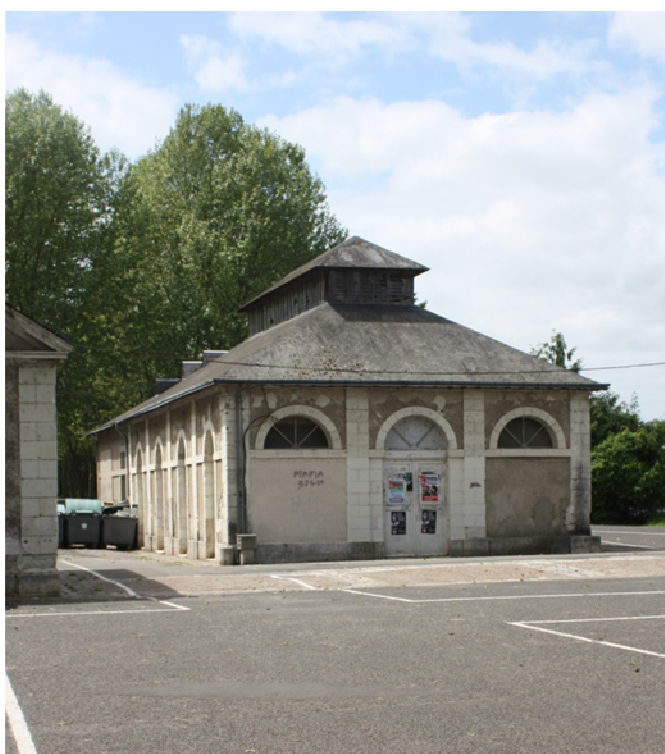
Illustration 43 - Bâtiment principal de l'ancien abattoir
