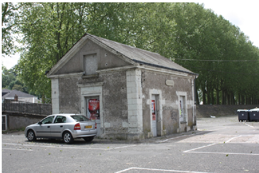
Illustration 44 - Bâtiment utilisé comme local technique pour le marché (photographie : Anne Cabaret)
