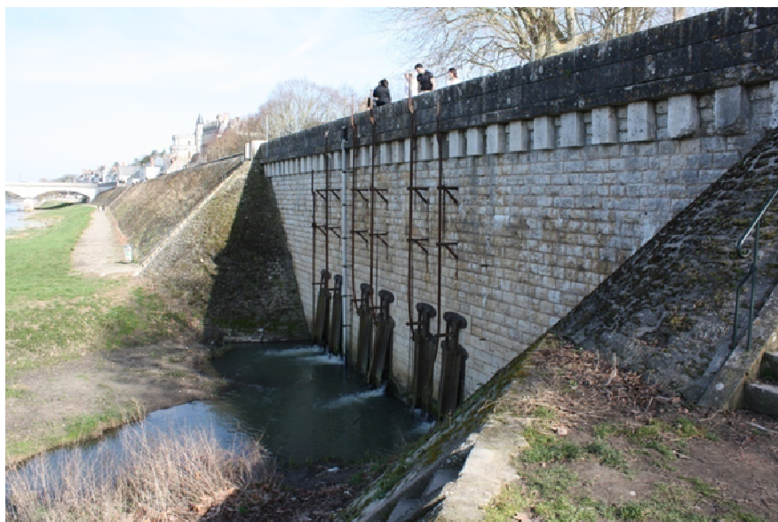
Illustration 48 - Sortie de l'Amasse souterraine
