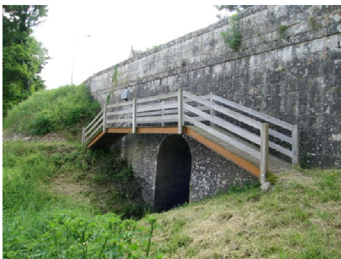
Illustration 49 - Passerelle bois pouvant être utilisée pour enjambrer l'Amasse
