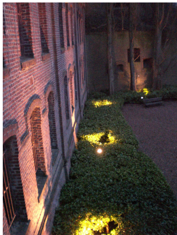
Photo 9: Façade du Fort de Mons
