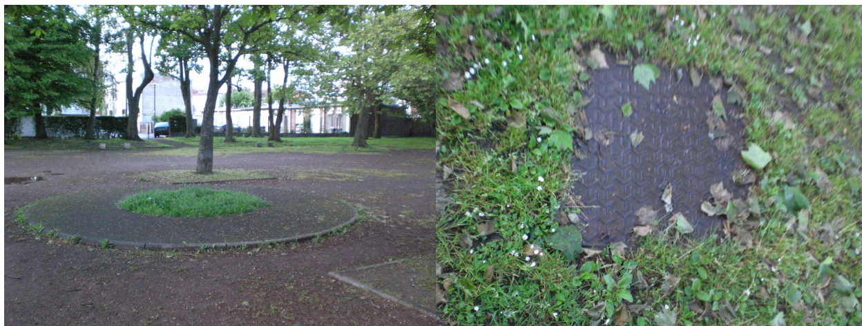
Photo 24 : Des reliefs inutiles et des plaques d'égouts qui ressortent
