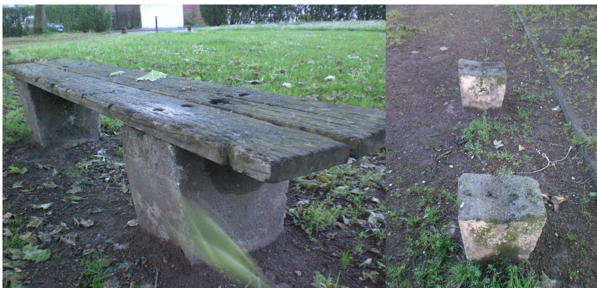
Photo 23 : Les bancs dégradés voir même arrachés
