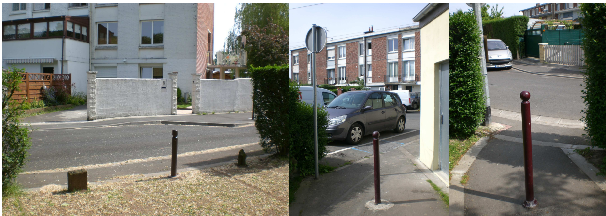
Photo 26 : Dispositifs de stoppage des véhicules motorisés
