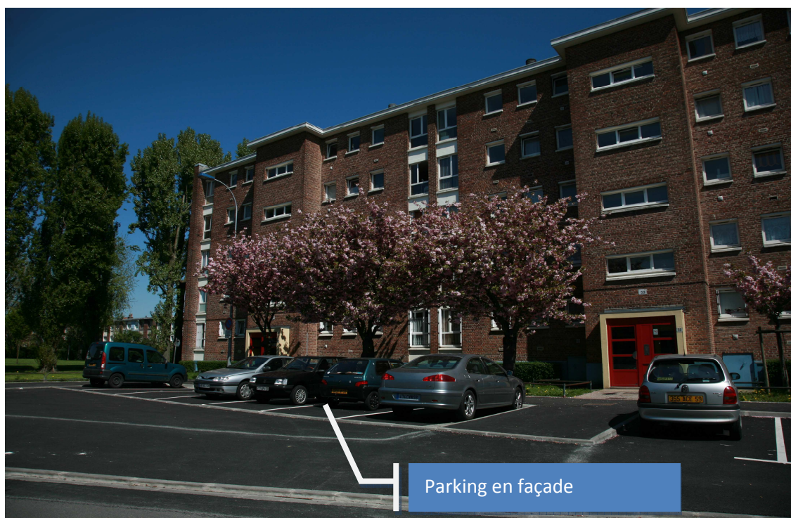
Photo 11 : La barre de logements collectifs R+5 de l'îlot Berlioz
