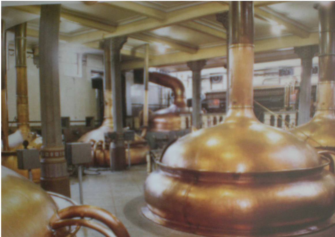
Photo 8 : La salle des cuves de la brasserie Heineken
