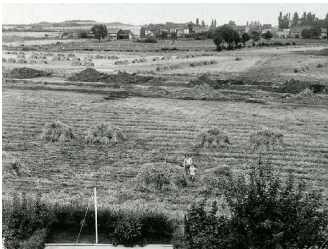
Photo 1 : Quartier des Sarts au milieu du XIX ème siècle
