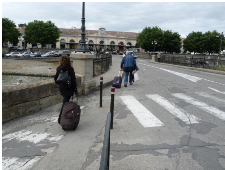
Figure 31 Un trottoir sans rampe qui incommode les usagers - Réalisation personnelle
