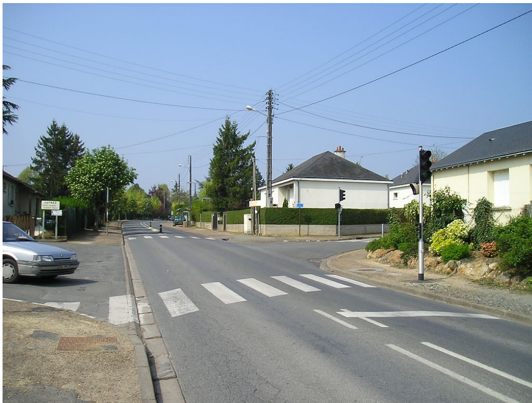
Photo 20: Carrefour Avenue du Duc de Luynes, Avenue du Général de Gaulle (à gauche) et Rue du Petit Verger (à droite)
