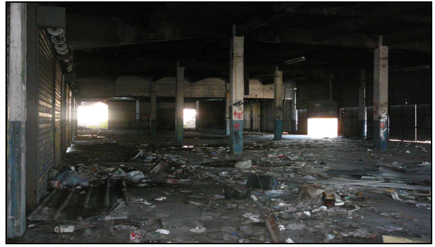
Photo 17. Intérieur des anciens frets SNCF Source : Réalisation personnelle
