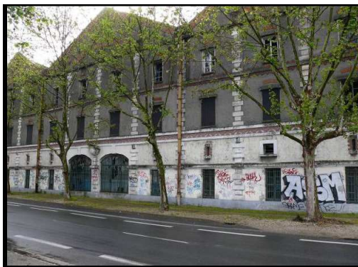
Photo 14. Le bâtiment des magasins généraux de la Caserne Niel
