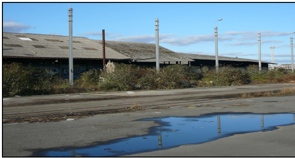
Photo 19. Anciens rails Source : Réalisation personnelle
