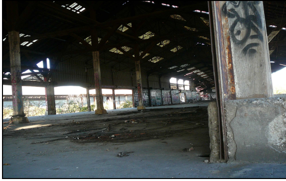
Photo 16. Intérieur des anciens frets SNCF Source : Réalisation personnelle
