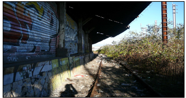
Photo 18. Anciens rails Source : Réalisation personnelle
