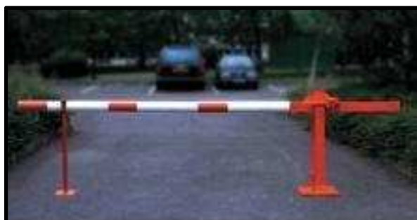
Photo 43 : barrière levante manuelle.
