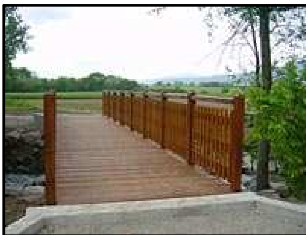
Photo 46 : passerelle en bois.
