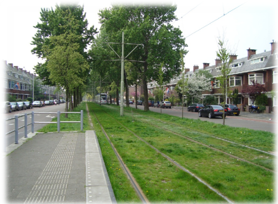
Photo 28 : Une voie de tramway à La Haye aux Pays-Bas, un exemple de végétation à suivre (source : réalisation personnelle)
