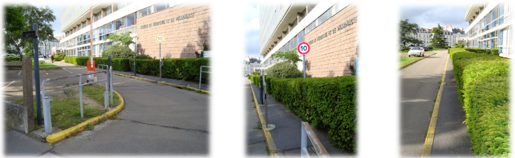
Photo 30 : L'entrée inappropriée, empruntée par les étudiants (source : réalisation personnelle)
