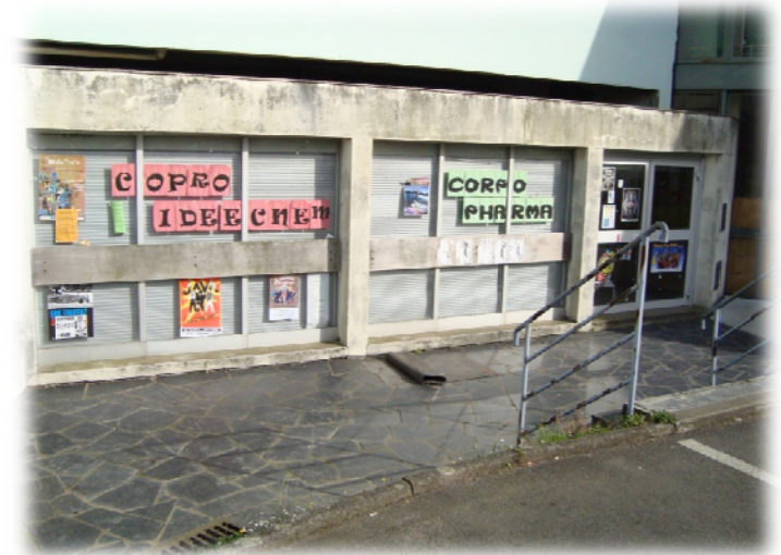
Photo 42 : La façade de la Corpo Médecine et Pharma (source : réalisation personnelle)
