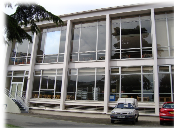
Photo 8 : Les baies vitrées de la façade arrière du RU et la terrasse-parking (source : réalisation personnelle)
