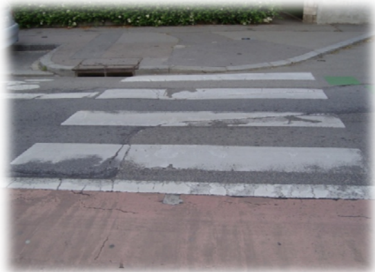
Photo 29 : La rue Gaston Veil ; un passage piéton et des trottoirs détériorés (source : réalisation personnelle)
