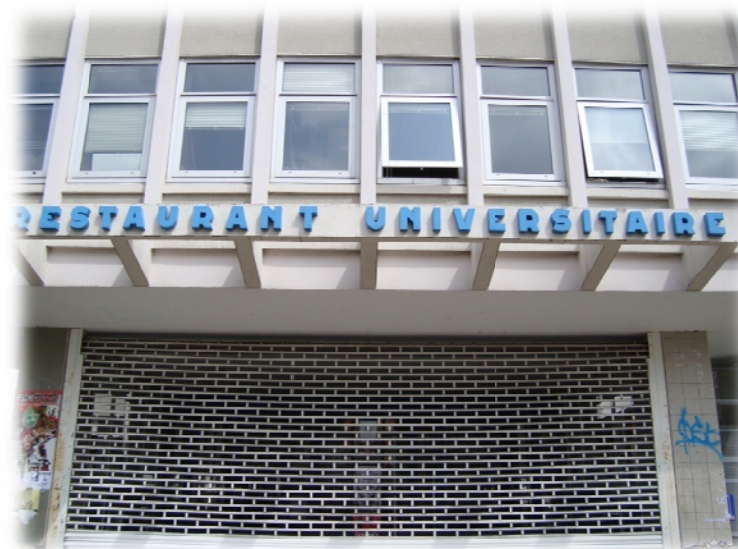
Photo 9 : La grille d'entrée du RU (source : réalisation personnelle)
