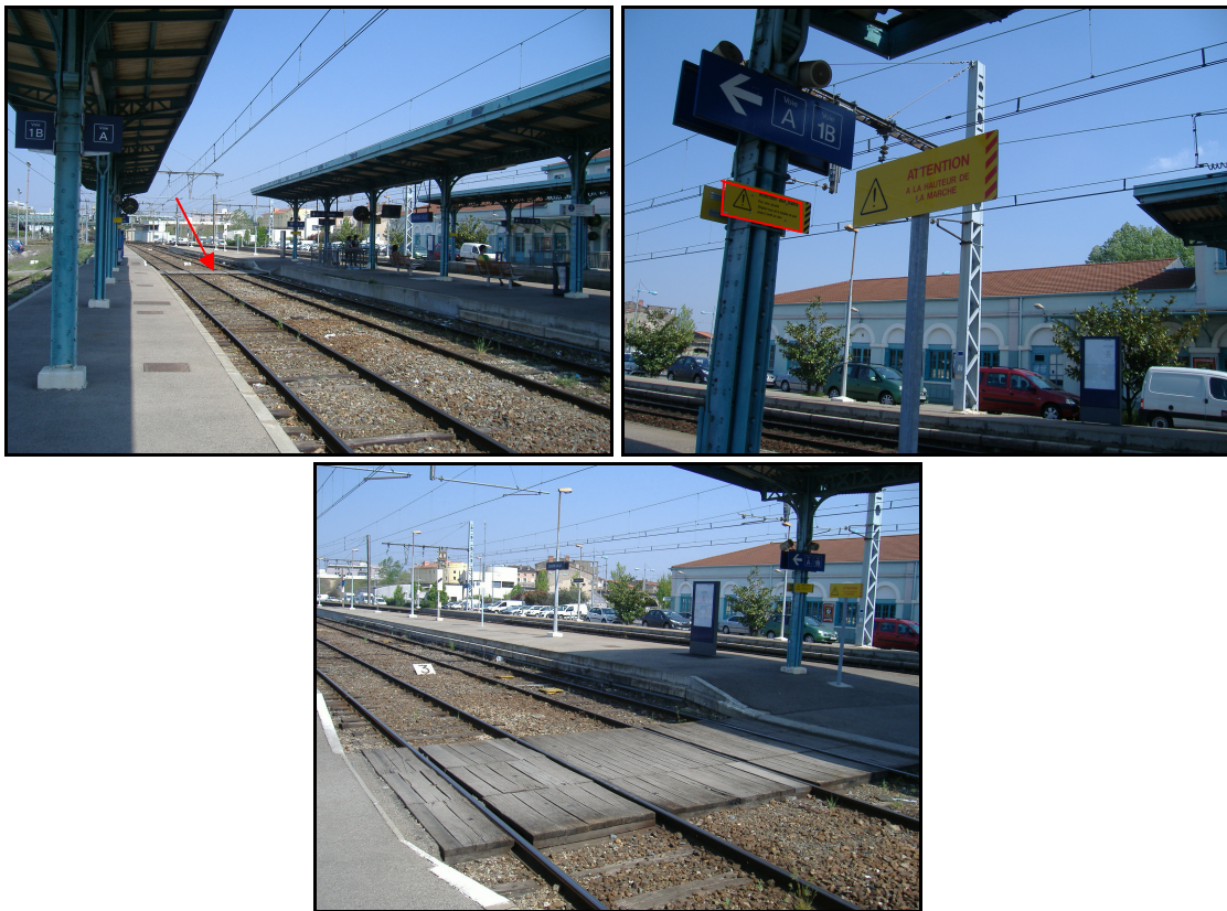
Photo 16: Accès non protégé traversant la ligne ferroviaire. Source personnelle
