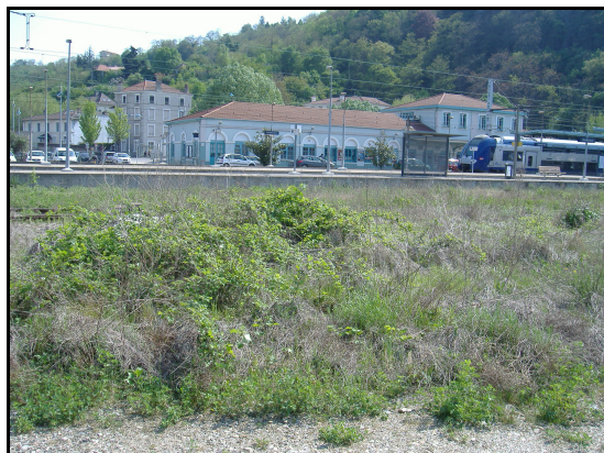
Photo 11: Arrière de la gare non entretenu. Source personnelle
