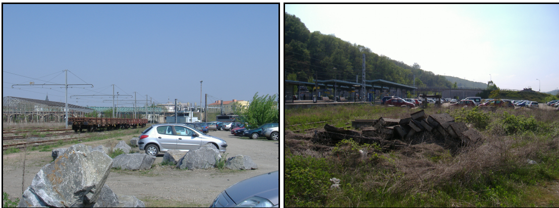
Photo 18: Structure en acier restant de VMC et traverses entassées. Source personnelle
