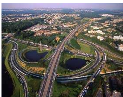
Vue aérienne de l'échangeur de Bois d'Arcy source: www.yvelines.fr/
