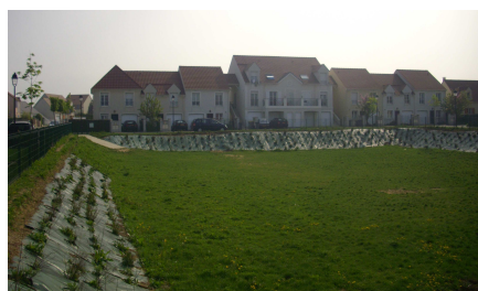
Photo 37 : Bassin de rétention du lotissement du Moulin à Vent
