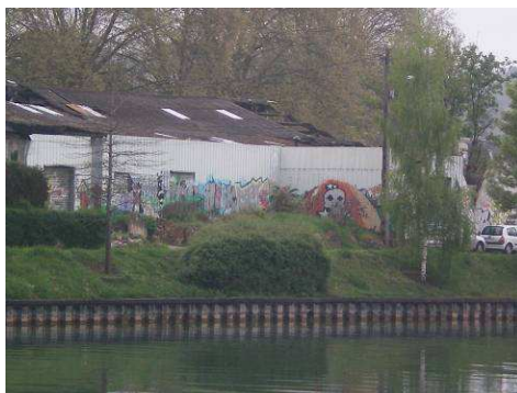
Photo 15: Vue des bords de Marne, friche et bâtiment dégradé
