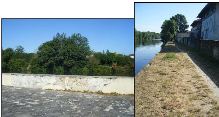
Photographie 28 : Mur de protection à l'arrière des anciens abattoirs
