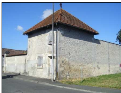
Photographie 37 : Le bâtiment choisi, vu de la rue des Gabariers
