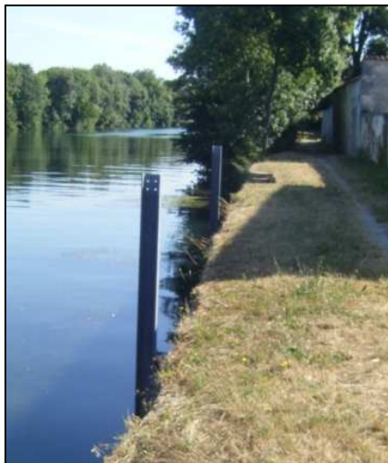
Photographie 41 : Equipement de fixation du ponton
