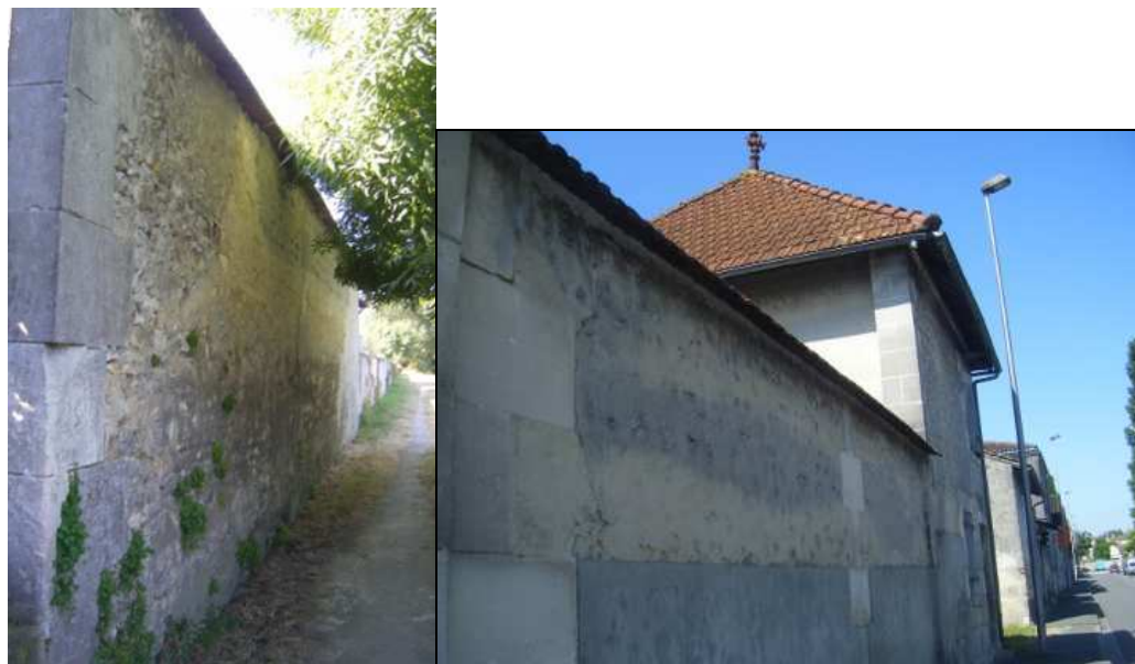
Photographie 42 : Le mur côté rue
