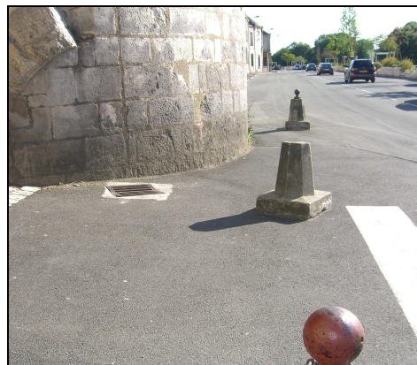
Photographie 53: Absence de trottoir pour les piétons devant les tours Saint-Jacques
