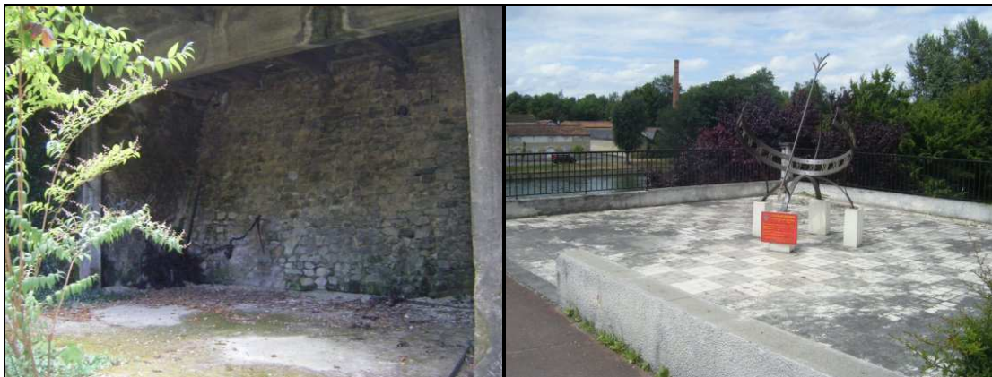
Photographie 90 : Espace laissé à l'abandon sous le pont Saint-Jacques Photographie 91 : Le cadran solaire sur la plateforme au dessus du square
