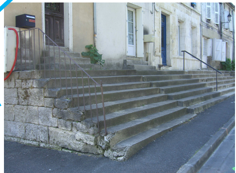
Entrées de maisons place du Soleçon
