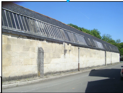
Façade donnant sur la rue des Pontis
