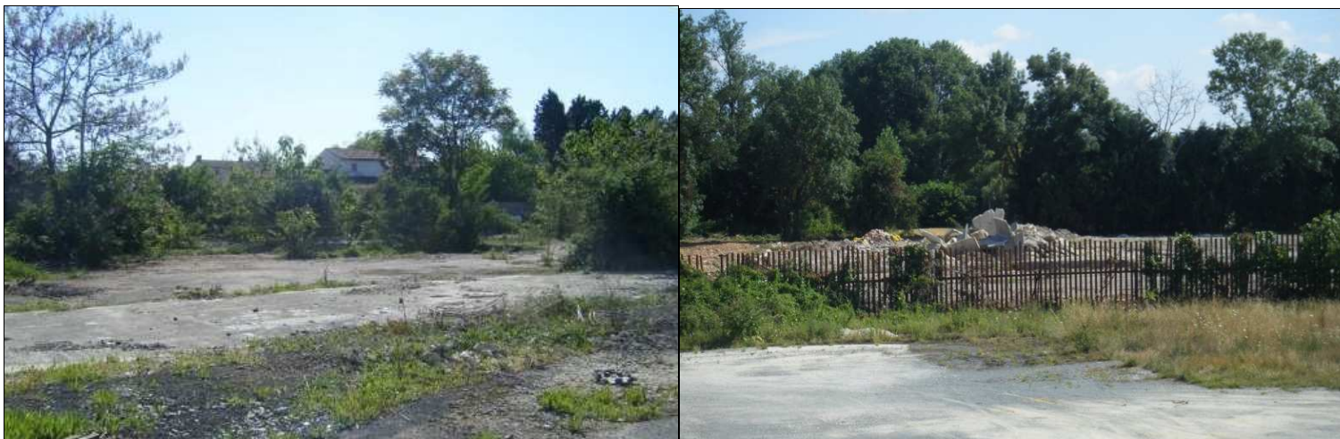
Photographie 5 : La parcelle Onyx au début des travaux de dépollution
