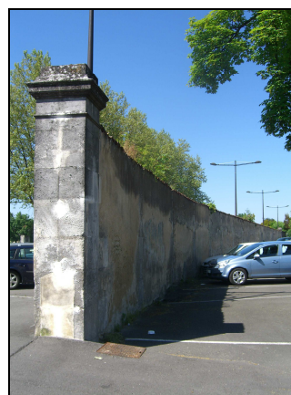
Photographie 83: Mur d'enceinte du parking de la Salle Verte
