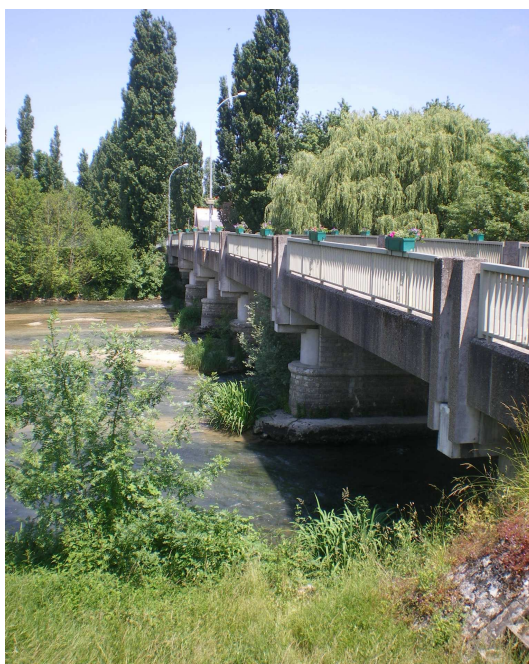
Photo n° 4 : Vue sur le pont du bourg de Reignac-sur-Indre
