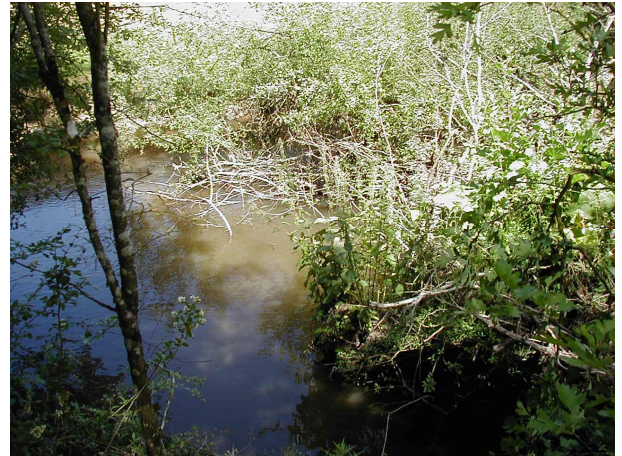
Figure 11 : La brèche vue coté fossé
