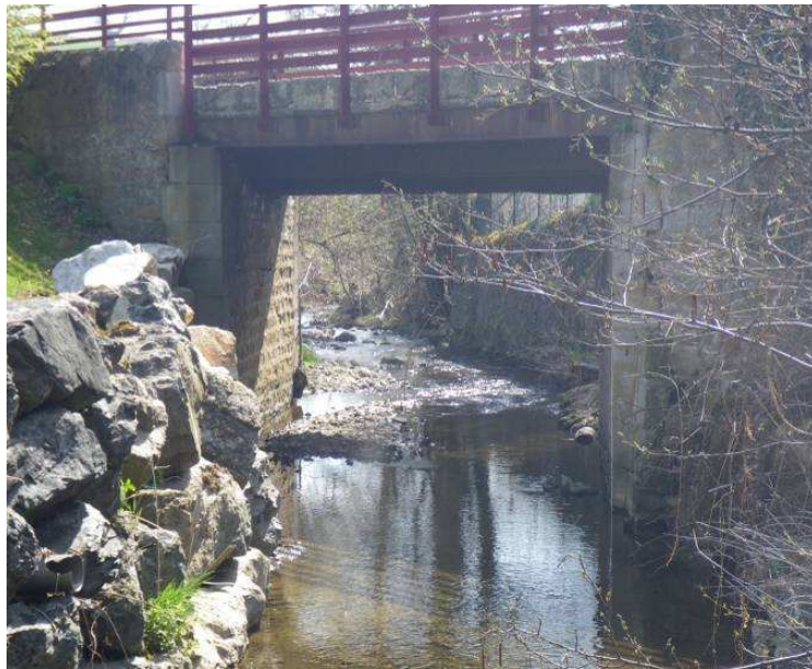
Figure 17 : Vue amont du pont rue de l'Entente
