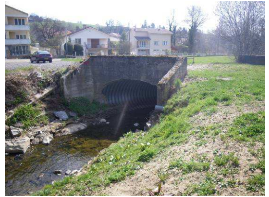
Figure 18 : Photographie du pont profil 36.5
