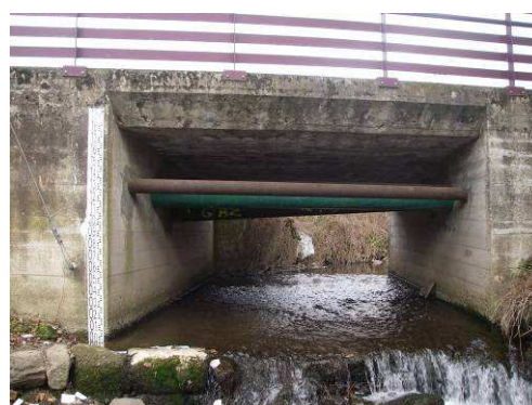
Figure 13 : Photographie du pont de la rue du Puits Pointu
