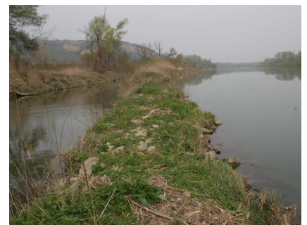
Figure 22: Photographie de la digue longitudinale en aval de la lône de la Boussarde (source CNR)
