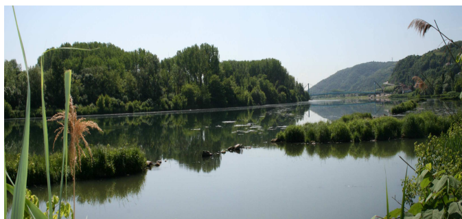
Figure 9: Photographie de la brèche sur l'épi aval de la lône de la Boussarde (source CNR)
