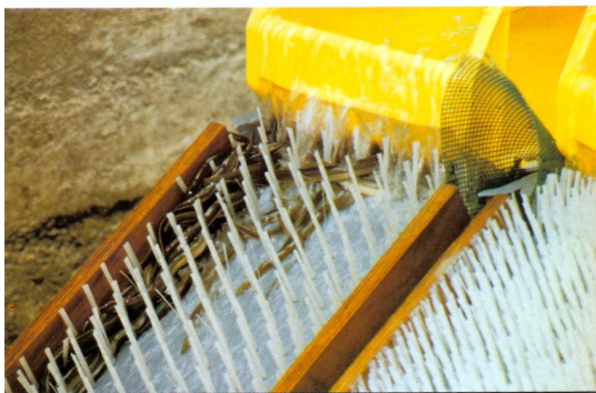
Figure 4 : Photo d'une brosse à anguille (Larinier)
