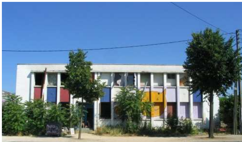
Façade avant des tanneries donnant sur le Boulevard de Chicago
