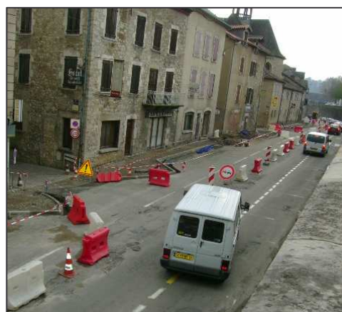
Travaux du boulevard Haute Guyenne Auteur : Aurélie Gineste
