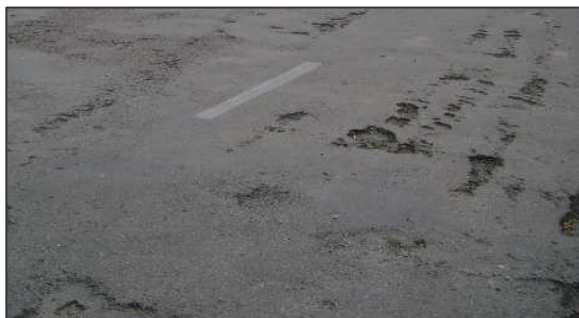
Revêtement du sol du parking du côté pair des allées
