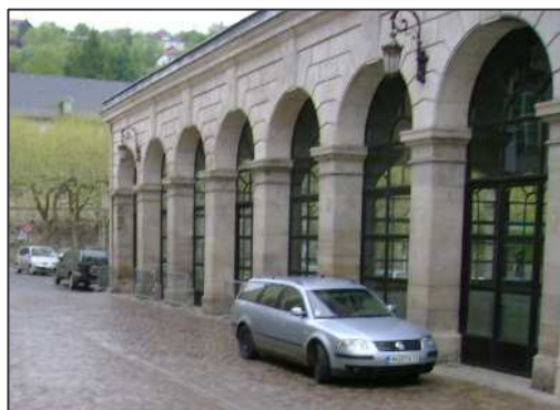
Façade Nord de la halle, accès principal à l'intérieur de la halle
