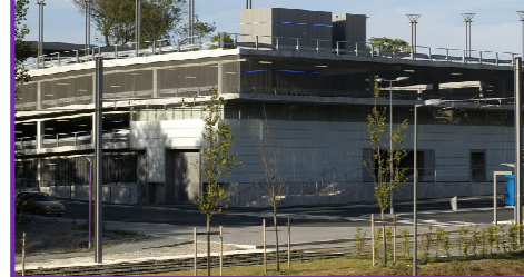
Photographie 6: Pôle relais de Lormont-Lauriers, source : PADD
