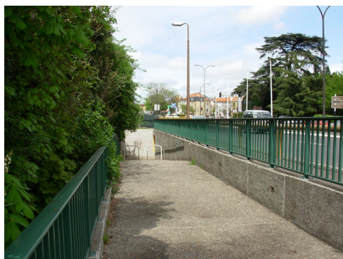
Photo 51 : Tunnel traversant la National 9 Source : personnel
