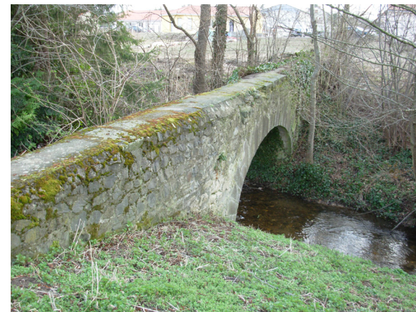
Photo 10 : Aqueduc le long de l'Ambène Source : personnel
