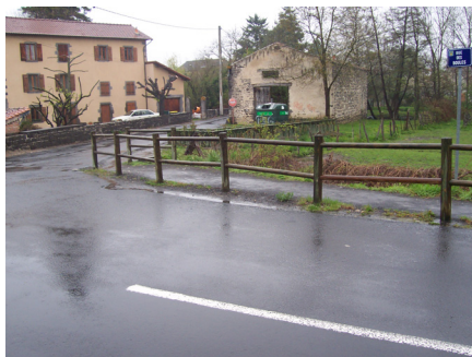
Photo 50 : Rambarde en bois existante Source : personnel
