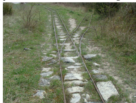
Photographie 66: L'ancienne voie ferrée menant à la carrière
