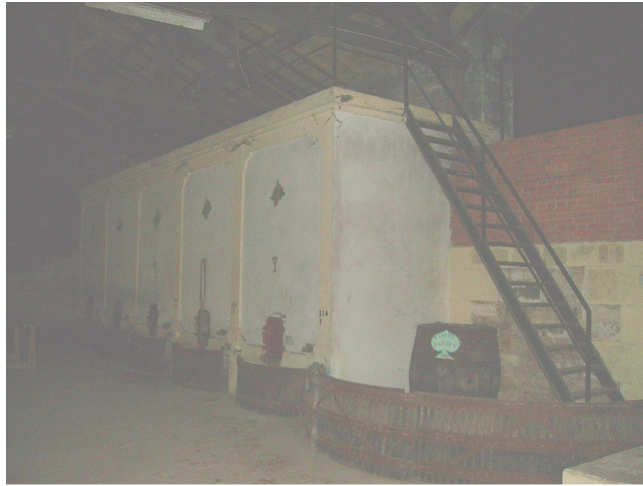
Photographie 56: Les cuves du domaine
