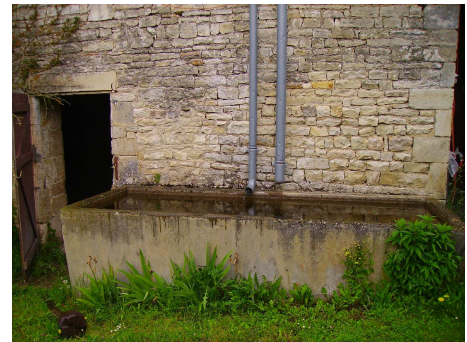
Photographie 49: Cuve de récupération des eaux
