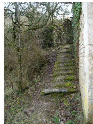
Photographie 45: L'escalier des Fours à Chaux
