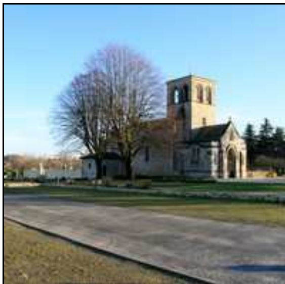
Photo 12 Eglise romane Source: site officiel de la ville d'Artigues.
