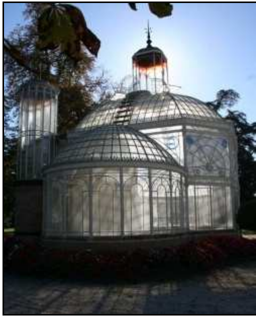
Photo 19 Serre du parc qui a été entièrement reconstruite
