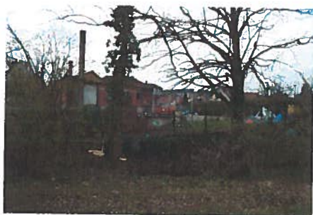
Photographie 32 : Façade arrière visible du chemin
