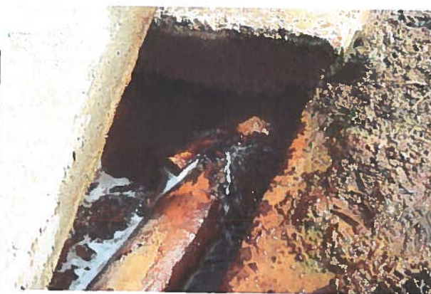
Photographies 17 et 18: Les canalisations d'eau chaude reliant la source à l'ancien hôtel thermal. Ces canalisations sont peu profondes, en partie déterrées et percées en plusieurs endroits
