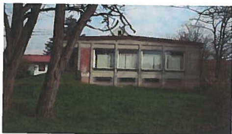
Photographie 33 : façade arrière de l'établissement Engel
