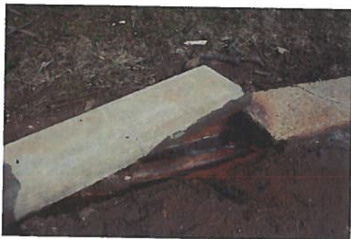
Photographies 17 et 18: Les canalisations d'eau chaude reliant la source à l'ancien hôtel thermal. Ces canalisations sont peu profondes, en partie déterrées et percées en plusieurs endroits
