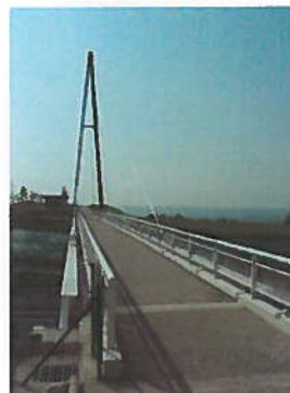
Aire de la Baie - Passerelle piétonne http://www.manche.equipement.gouv.fr/route/a84.html
