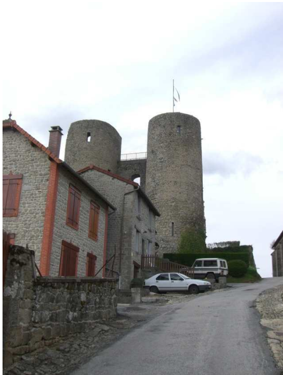
Photo 21 : des constructions anciennes en pierre et des traces des anciennes rues pavées
