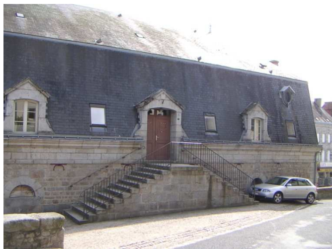
Photo 15 : la salle des fêtes se trouve au-dessus des halles
