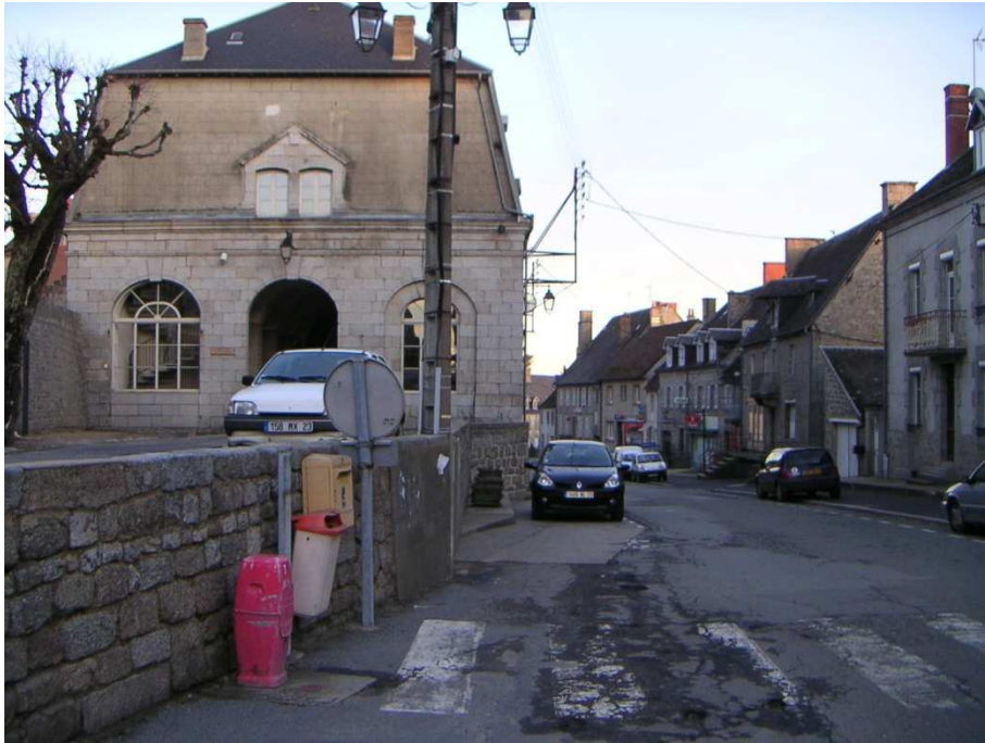
Photo 33 : un mobilier public ancien et une voirie mal entretenue
