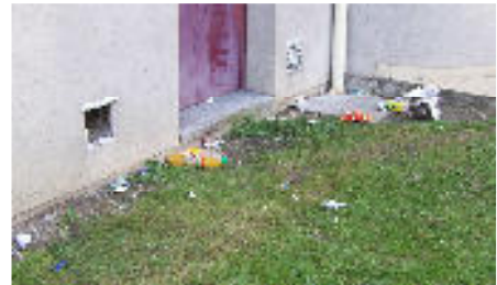
Photo 7 : Devant le bâtiment 2 20
