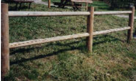
Photo 15 : Clôture bois 2 lisses 26
