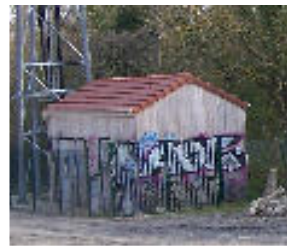
Photo 3 : le local proche de l'antenne 16
