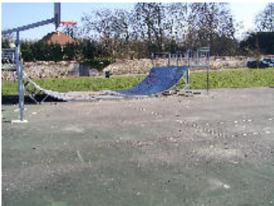
Photo 1. : les dégradations sur le mini pipe 13
