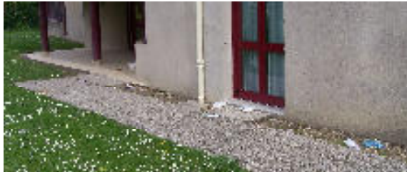
Photo 6 : Devant le bâtiment 1 19
