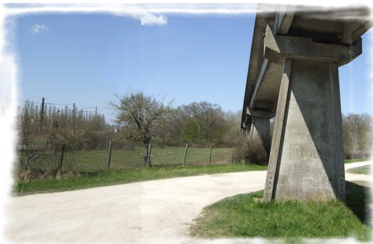
Photographie 3 : Rails de l'aérotrain parallèle à la voie ferrée et à la R.N.20 à Saran Source : Julie ROUSSELIE
