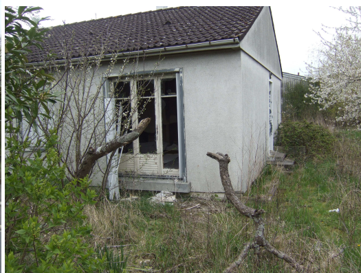
Photographie 15 : Vue de l'est de l'îlot : le pavillon Source : Julie ROUSSELIE
