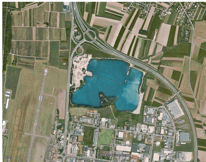
Photo 18 : Vue aérienne de la gravière de Colmar-Houssen
