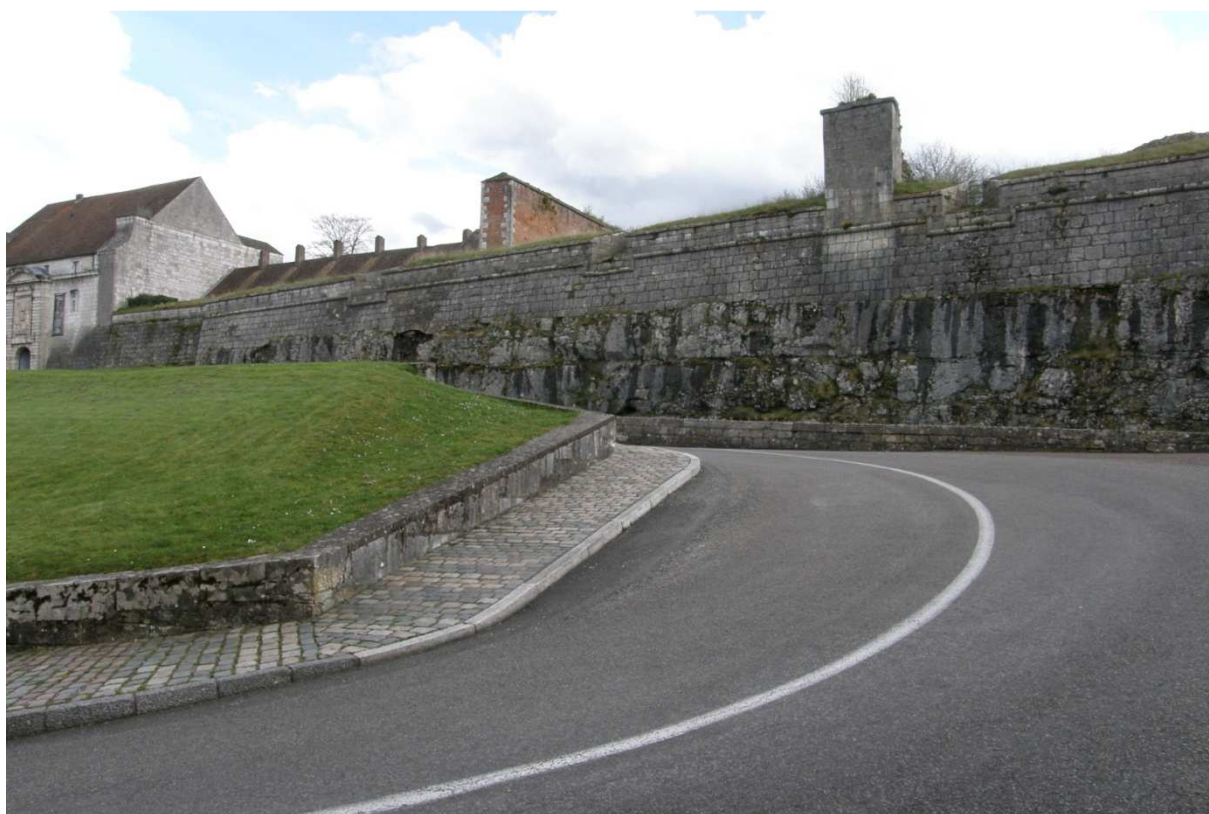
Photo n°15 : Dernier virage pour l'accès au parking de la Citadelle
