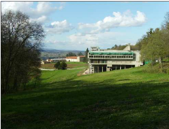
Travaux de rénovation des loggias sur la face sud du couvent
