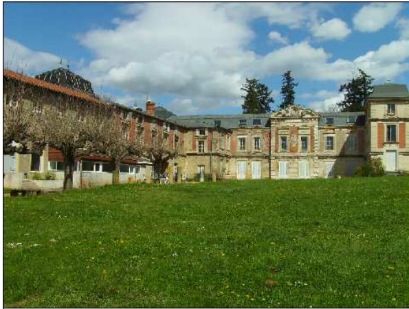
Photo de la façade sud du château de la tourette
