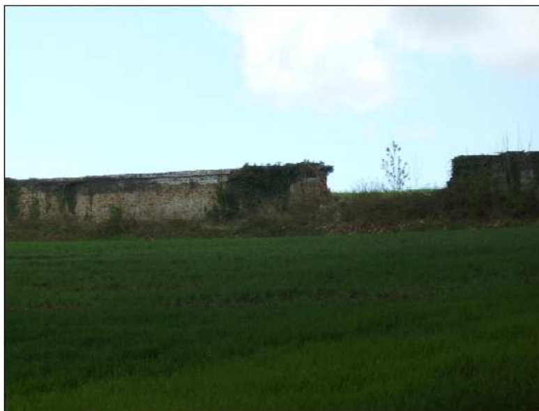
Mur vandalisé encerclant le domaine
