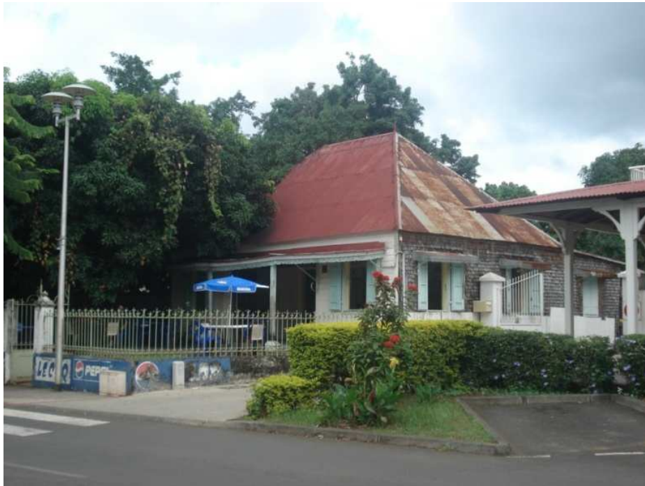
Photo n° 22 : Case à l'origine du périmètre protégé par les Bâtiments de France
