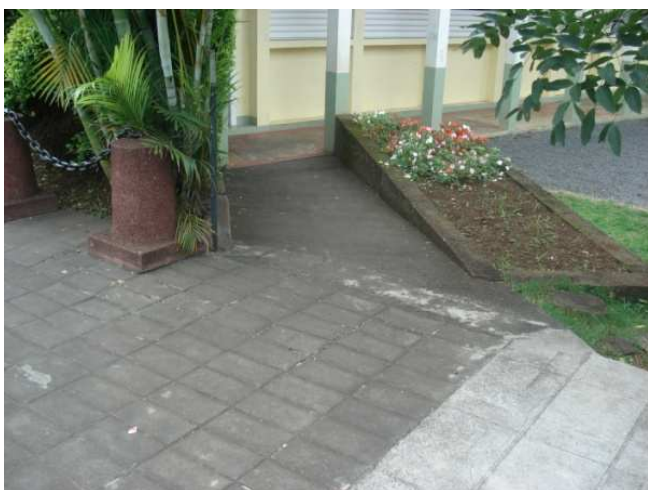
Photo n° 27 : Accès handicapés aux organismes situés sur la 2 ème partie de la place
