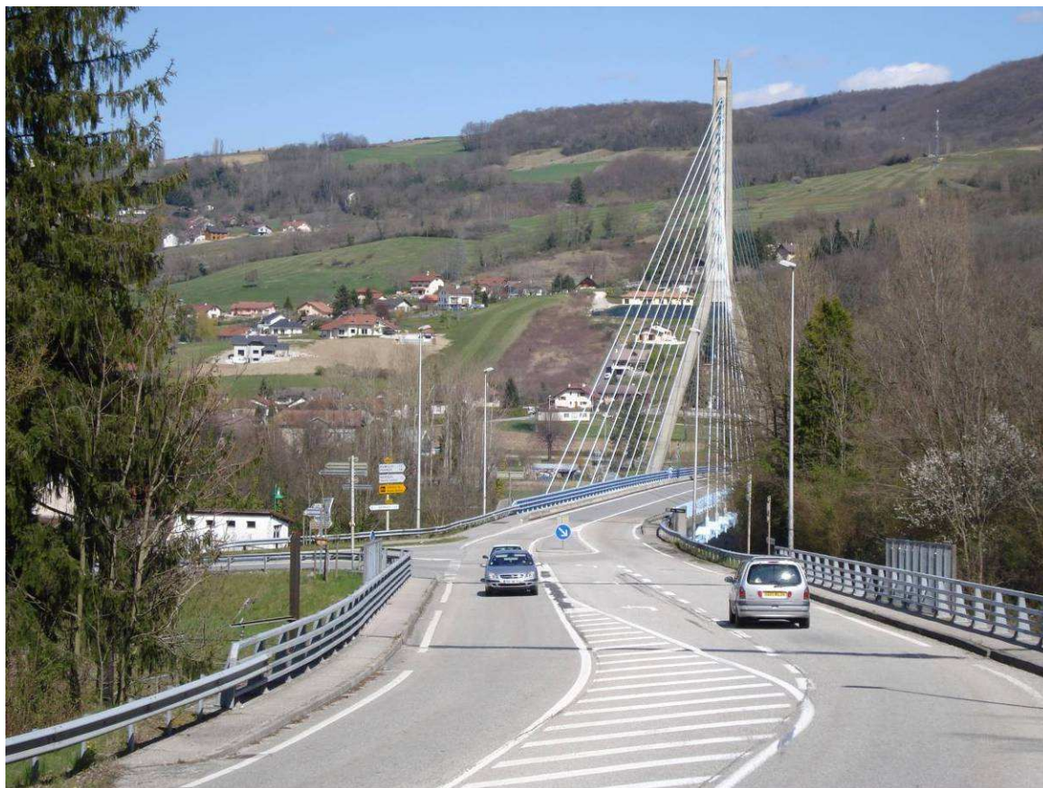
Photo 6 : Vue de la RD 992 – Entrée Sud de Seyssel et pont sur le Rhône
