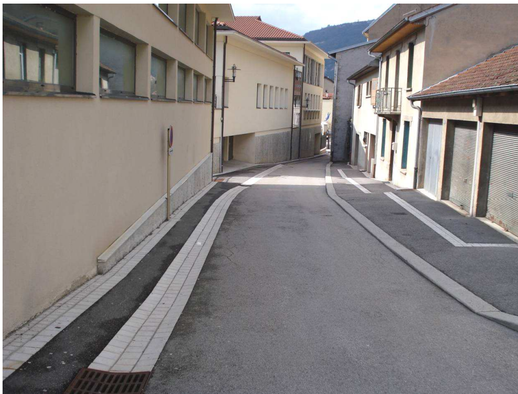
Photo 37 : Séparation de la chaussée et des accotements – Ville de Nantua
