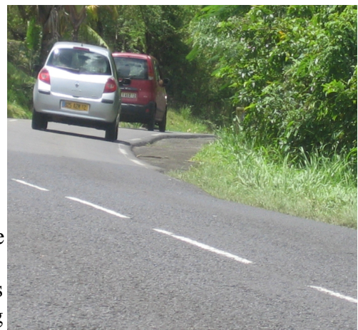
Discontinuité du trottoir, source: photo personnelle
