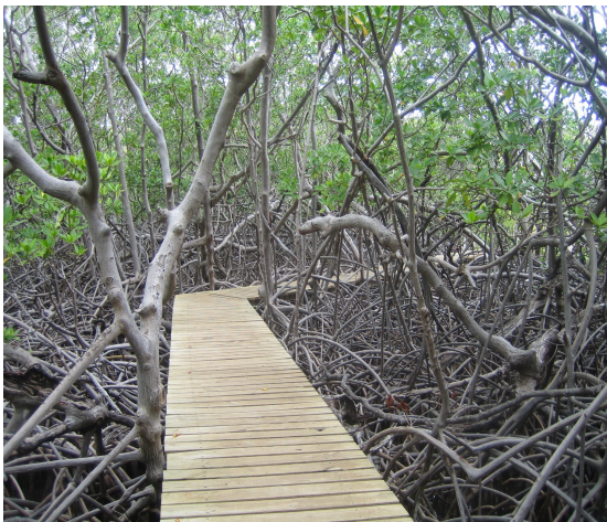
Un exemple de platelage de franchissement dans la mangrove de la Caravelle à Trinité, source: photo personnelle
