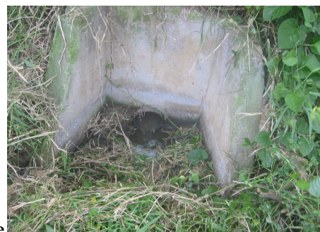
Rejet d'effluents dans la rivière, source: photo personnelle
