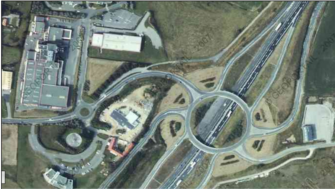
Figure 24: vue aérienne de la sortie autoroutière n°3 et d'une partie de la ZI
