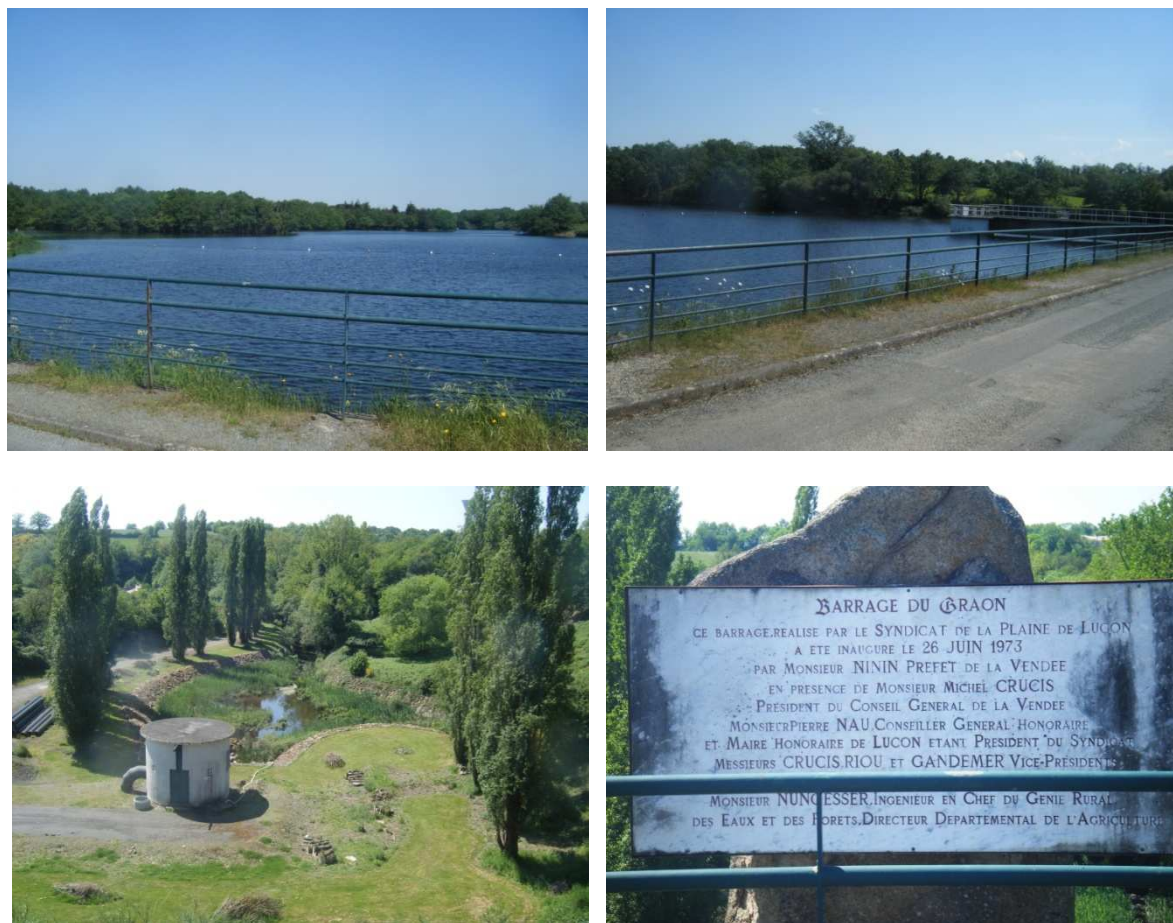
Fig. 35,36 : Vue de la retenue d'eau à partir du barrage
