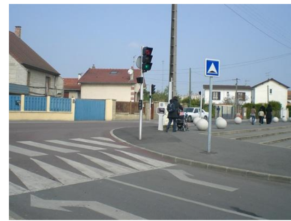
6- Carrefour surélevé à feux rue Eric Tabarly
