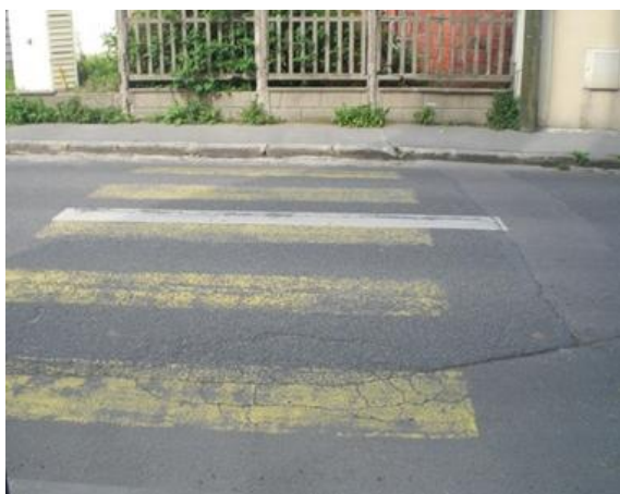
4- Passage piéton rue Jean Anouilh
