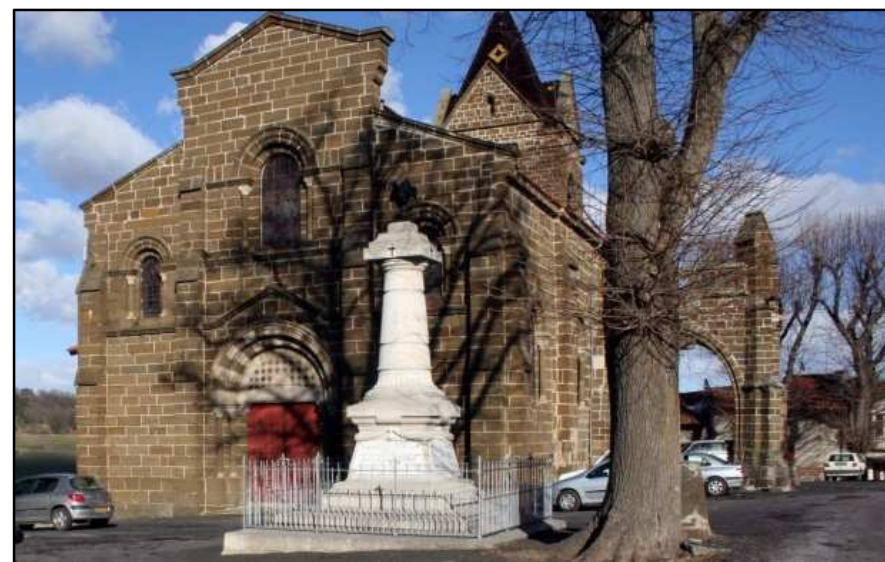
Photographie 13 : façade ouest de l'église
