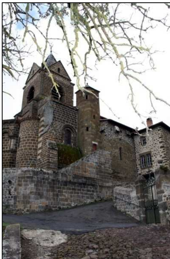
Photographie 10 : église, façade nord
