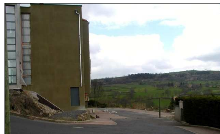
Photographie 24 : partie du parking, en construction, sous la nouvelle école.
