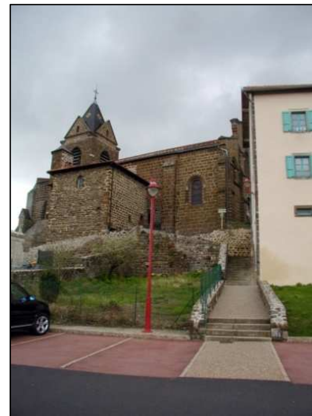
Photographie 26 : accès au parking par le chemin qui encercle l'église.
