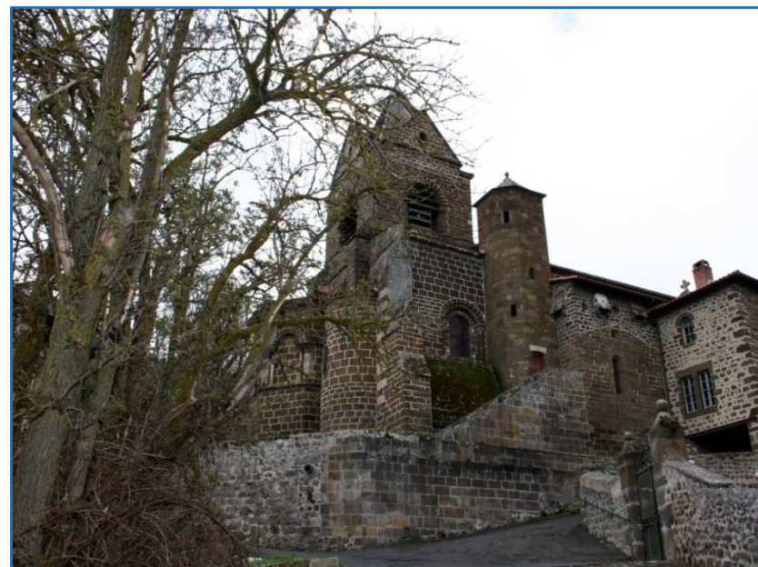
Photographie 37 : église, façade nord
