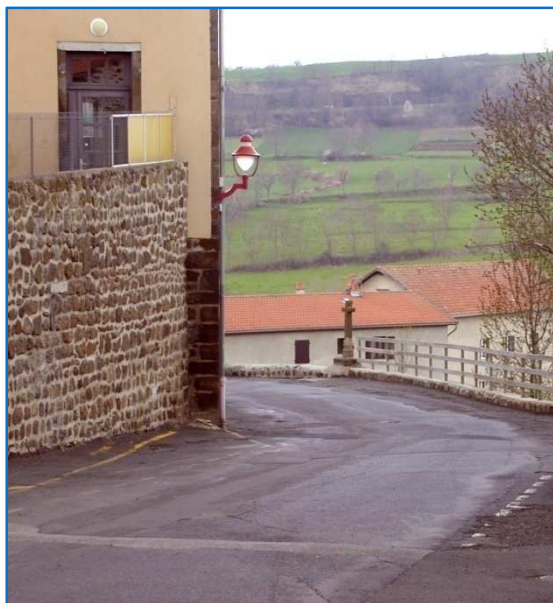
Photographie 38 : virage dangereux
