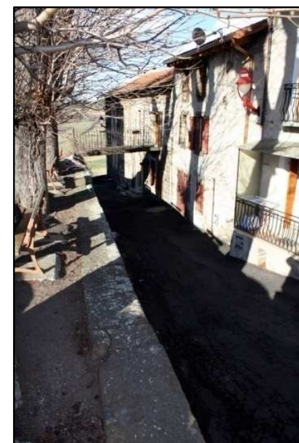
Photographie 21 : muret dangereux.
