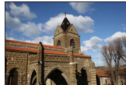
Photographie 8 : église, façade sud
