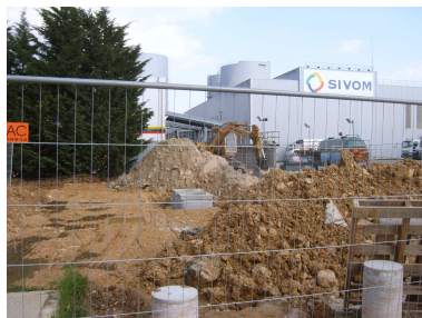
Photo n°1 : La pompe à diester actuellement en construction
