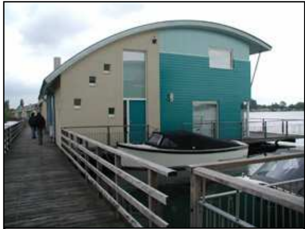
Photo 12 : Maison flottante aux Pays-Bas Source : www.etpb-loire.fr
