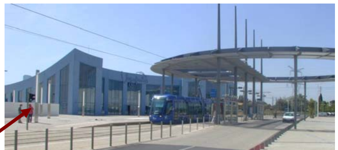
Arrêt Odysseum de la ligne 1, face à la patinoire Végapolis
