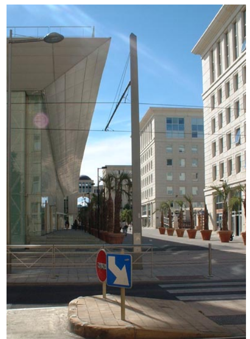
Figure n° 42 : Quartier Antigone, la piscine olympique
