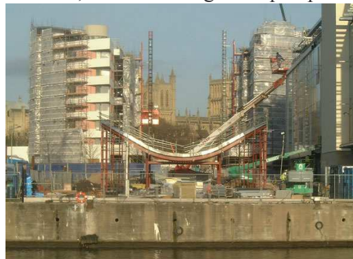
Figure 7 : chantier dans le quartier d'Harbourside
