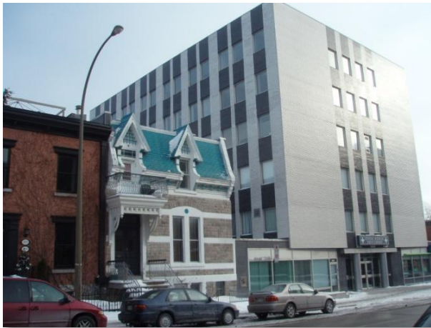
Photo 7 : Rue Saint Urbain – intégration ?
