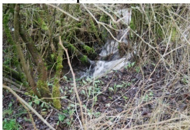
Vue depuis l'aval
