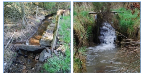
Figure 15 : Planche barrant l'écoulement (à gauche) sur le Ru du Chietet et ouvrage de dérivation d'un étang (Ru de la Voie Habay)
