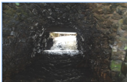
Figure 13 : Pont à arche avec une chute d'eau en amont de l'ouvrage (Ruisseau du Savipré).
