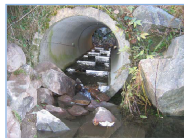
Figure 42 : Déflecteurs mis en place (en bas) pour aménager une buse (Life ruisseau, P. Durlet).
