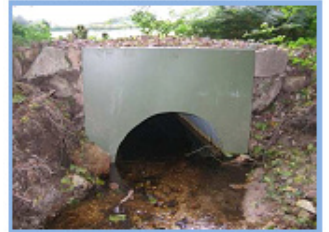
Arche métallique autoportée (P.Durlet)
