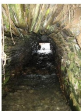
Vue depuis l'aval
