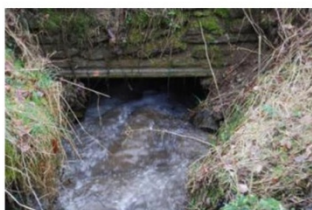
Vue depuis l'amont
