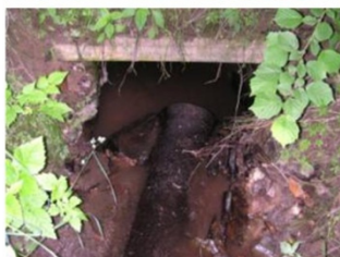
Vue amont le 18 juin 2008
