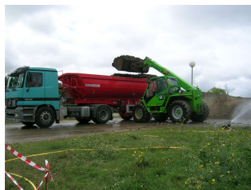
Figure 24 : Chargement des boues dans le camion - ND
