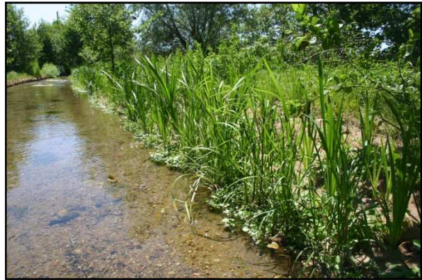
Figure 32: Exemple de boudins d'hélophytes végétalisés sur la Roguenette -28- (Crédit photo CE3E).
