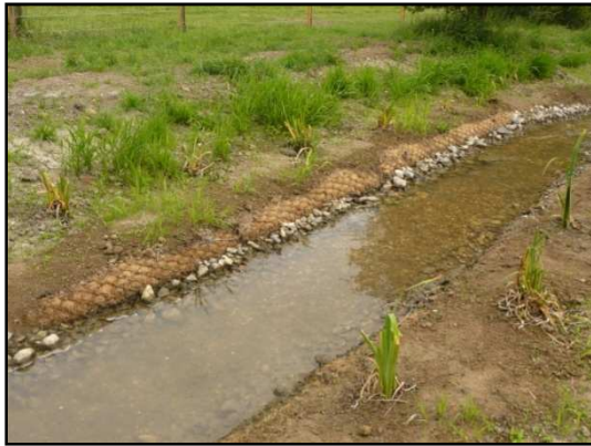
Figure 31: Exemple de banquettes et de boudins d'hélophytes sur le Trou à l'Ane (Crédit photo pers.).
