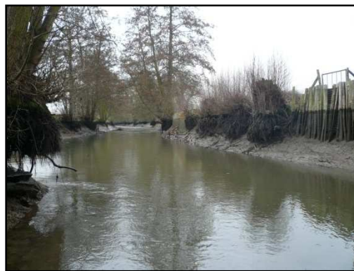
Figure 28: Ripisylve dénoyée sur la Blaise suite à l'arasement d'un ouvrage (Crédit photo CE3E).
