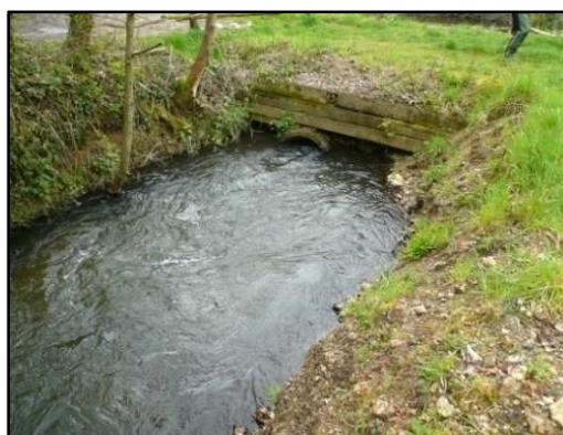
Figure 33: Extrémité aval de la buse.
