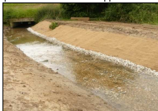
Figure 29: Berge talutée et recouverte d'un géotextile sur le Trou à l'âne- 28 -(Crédit photo pers.).
