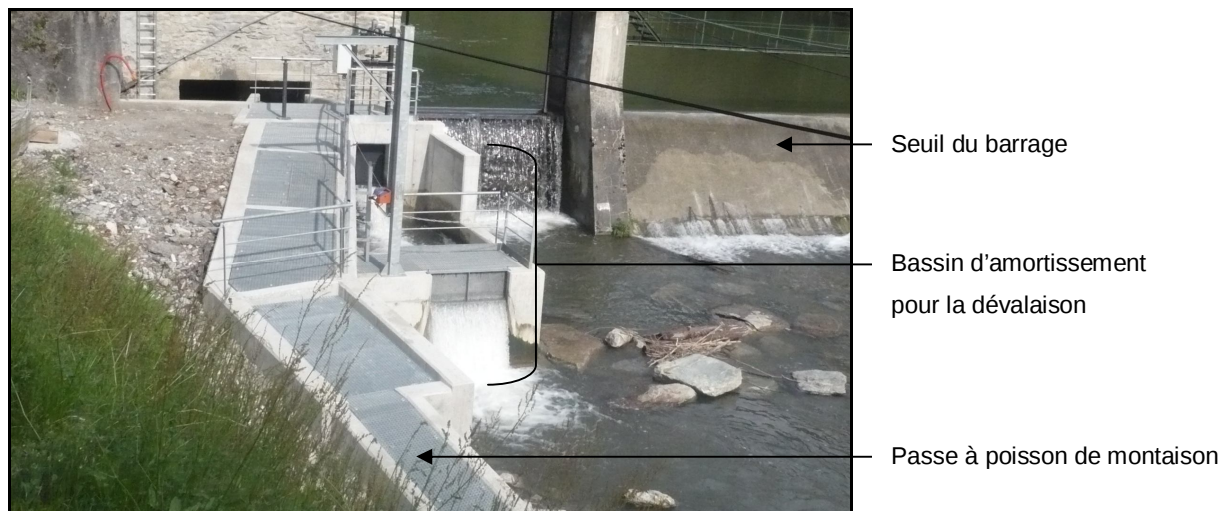
Figure 6 Photographie générale des principaux éléments du barrage de Queige
