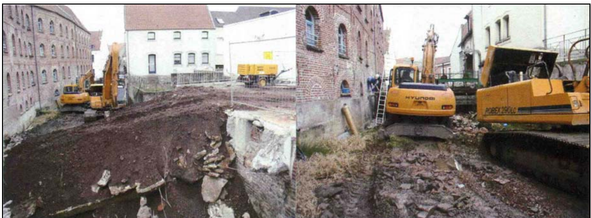
Figure 3 : Photographies de la mise en place d'une rampe d'accès pour le dérasement d'un barrage à Hesdin (62) sur la Canche (source : DDAF 62)
